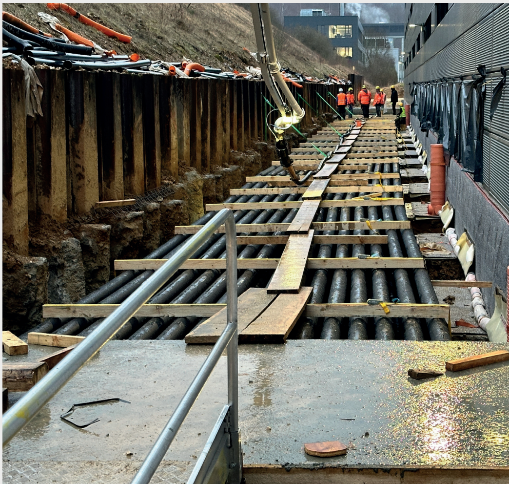
Schlauchverlängerung bis ca. 100 m möglich
